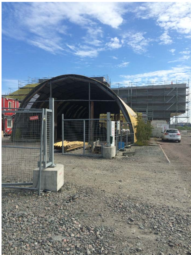
Arbete med nedmontering av gula hallen.
