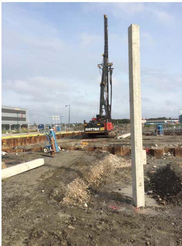
Spontning och pålning av kvarter N
