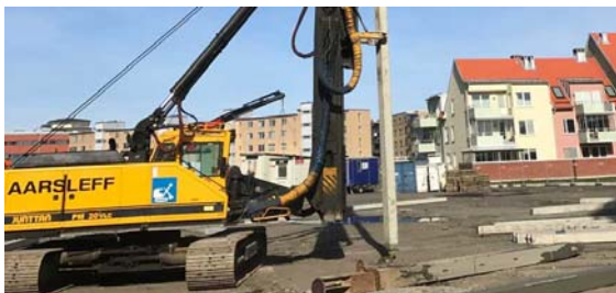
Pålning pågår april 2017 kv. Signalflyget 2
