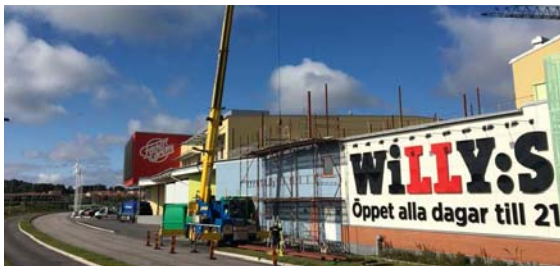
Pågående arbete Folk tandvårdens lokaler september 2017
