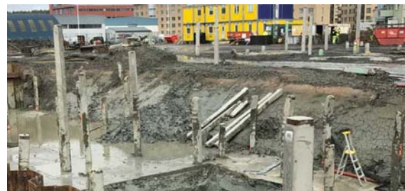
Pålning pågår Kv. Signalflyget II maj 2017.
