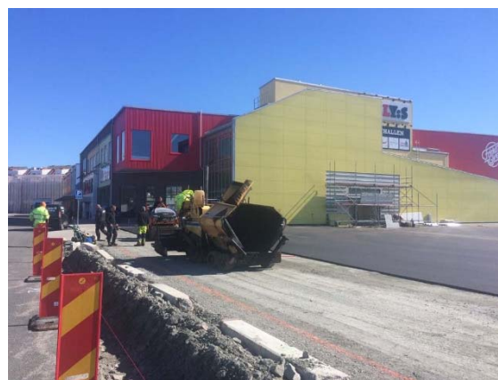
Arbete parkering utanför Willys april 2016.
